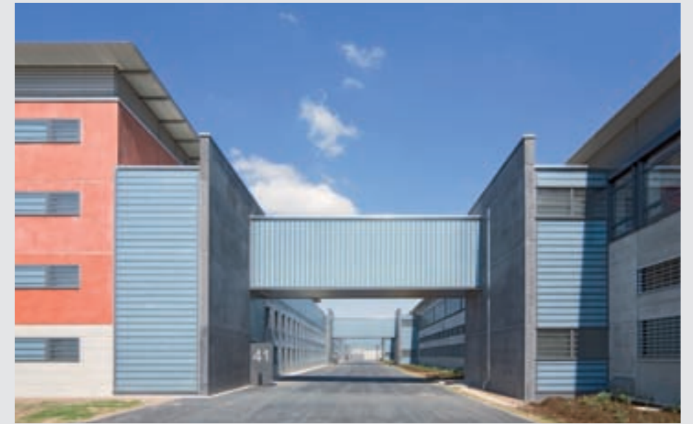
Blick in die Magistrale mit den Verbindungsbrücken
