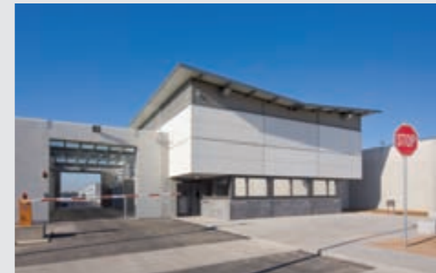
Torwachgebäude 11 mit Fahrzeugschleuse
